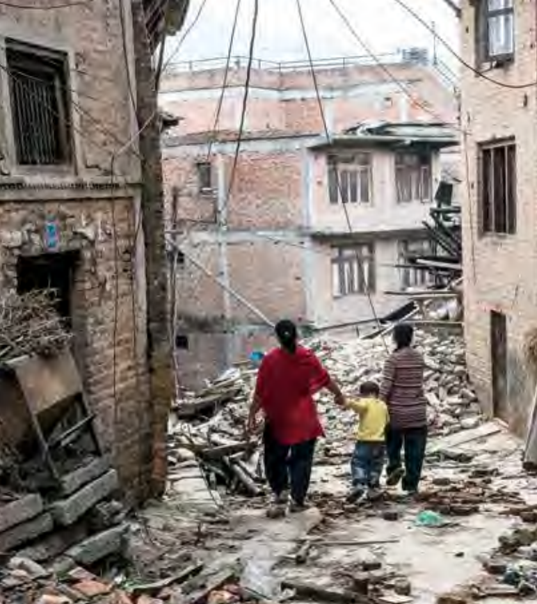
Khokhana dopo il terremoto, periferia di Kathmandu, Foto © Panos Pictures/Vlad Sokhin
